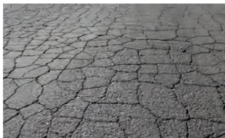
Рисунок.3. Сетка трещин
