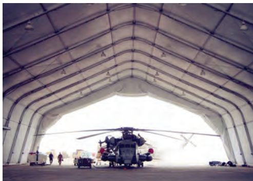
Рисунок 2. Воздухоопорное сооружение ангара, усиленное металлическими арками
