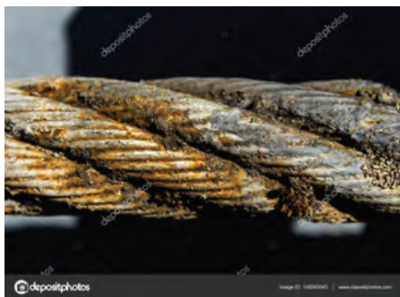
Рисунок 5. Коррозия металлического каната
