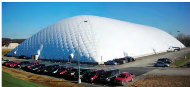
Рисунок 2. Воздухоопорное сооружение последнего поколения
