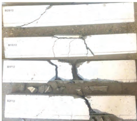
Рисунок 1. Характер разрушения опытных балок армированных
