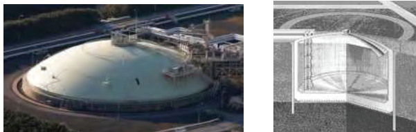
Рисунок 3 – Подземные резервуары СПГ
