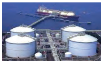
Рисунок 4 – Надземные резервуары СПГ
