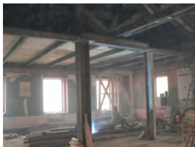
Рис. 3 Вид каркаса на 1 этаже после реконструкции
