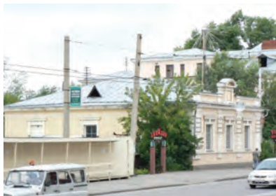
Рис. 1. Общий вид здания на момент обследования
