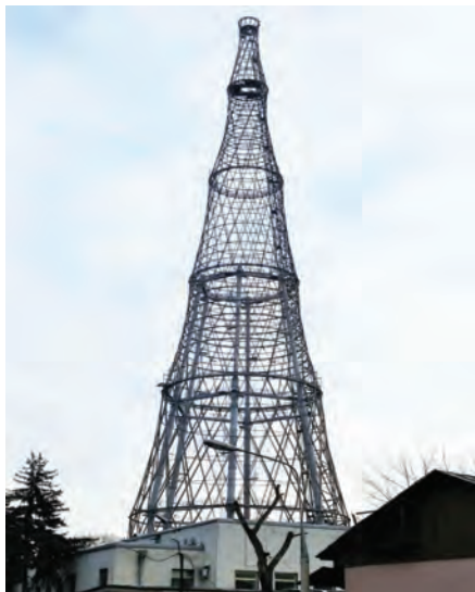
Рис.4 Завершение возведения опорной конструкции.
