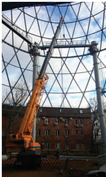
Рис.3 Возведение 1 - го уровня опорной конструкции.
