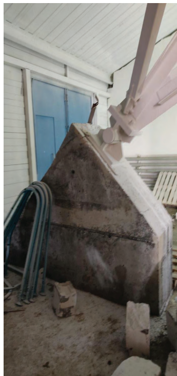
Фотография 2 – Монолитная железобетонная опора
