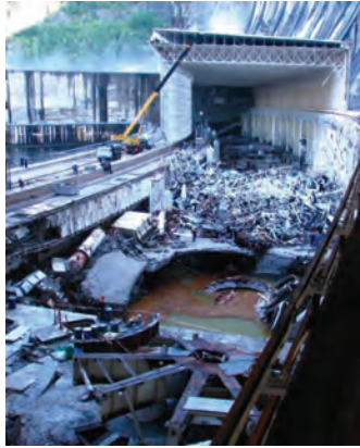
Фотография 1. Машинный зал после аварии
