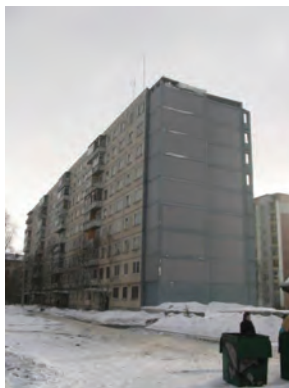
Фотография 1. Вид здания
