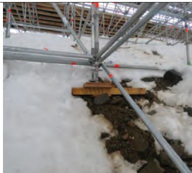
Фотография 6 – Общий вид и конструктивное решение опорных элементов стоек на откосе
