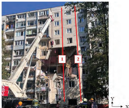
Рисунок 1 – Схема проведения геодезической съёмки здания в осях В / 3 - 5
