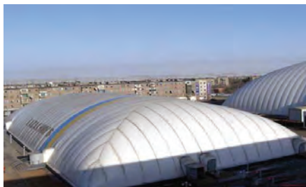
Рис.1 Воздухоопорные спортивные сооружения г. Харьков
