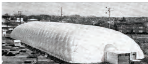
Рис.1. Воздухоопорное сооружение, усиленное канатами со средней ячейкой
