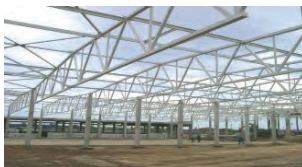
Рисунок 1 – Каркас здания из металлических конструкций
