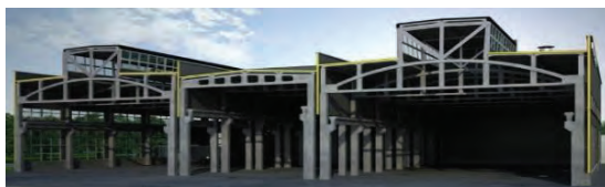
Рисунок 2 – Каркас здания из сборных железобетонных конструкций
