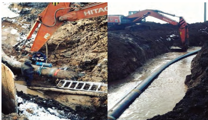
Рисунок 1. Условия выполнения работ по дефектоскопии сварных соединений
