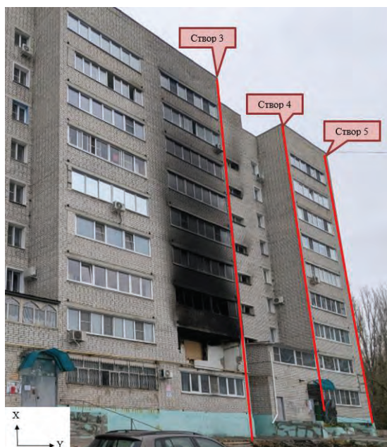
Рисунок 2 – Схема проведения геодезической съёмки с указанием мест измерения створов здания
