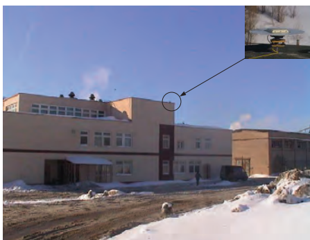
Рисунок 3 – Установка GPS антенны на крыше здания
