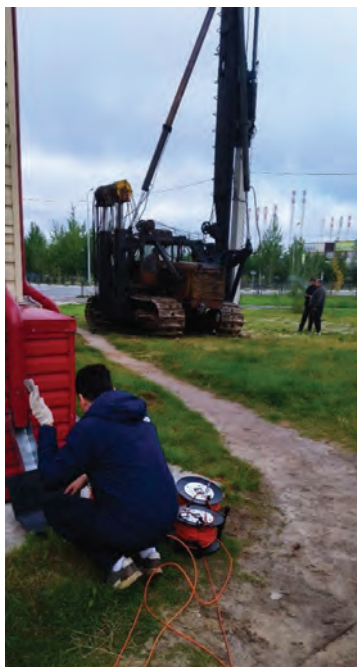
Рисунок 1 – Динамические испытания здания при забивке сваи
