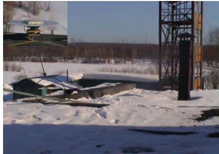
Рисунок 4 – установка GPS антенны на кровле гаражей
