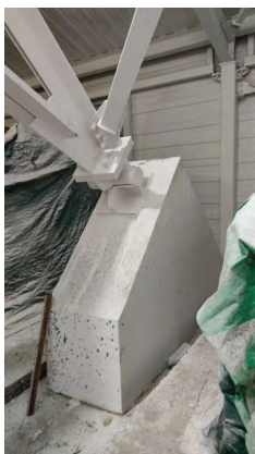
Фотография 1 – Стальная опора
