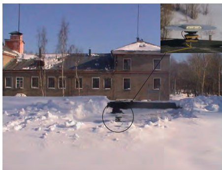
Рисунок 3 – установка GPS антенны на крыше здания
