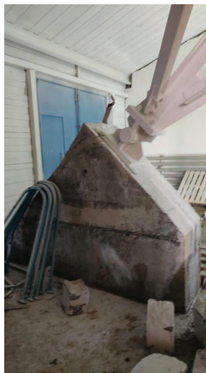
Фотография 2 – Монолитная железобетонная опора
