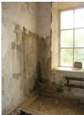
Рисунок 4 – Области намокания внутренней стены и образование грибка
