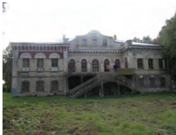
Рисунок 1 – Общий вид обследуемого здания с помощью визуального контроля
