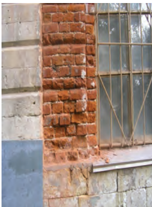
Рисунок 3 – Выкрашивание и выветривание кирпичной кладки, с образованием грибка
