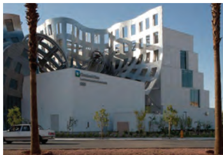
Рисунок 3 – Контраст северной и южной части здания
