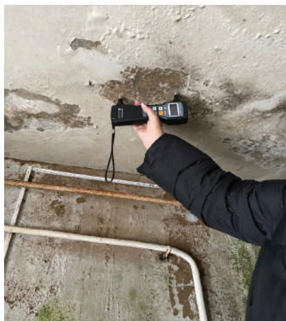
Фотография 4 – Измерения прочностью конструкций методом неразрушающего контроля
