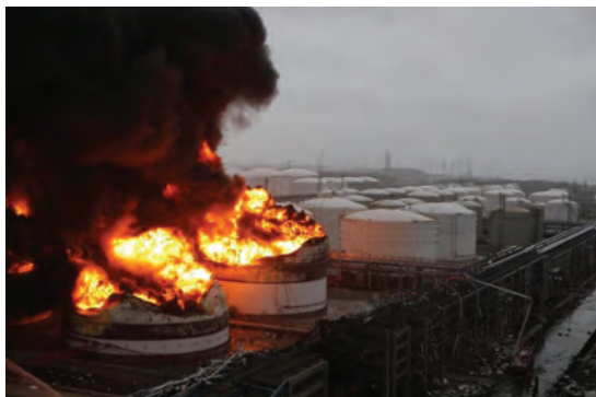
Рисунок 1 - Авария на производственном объекте.
