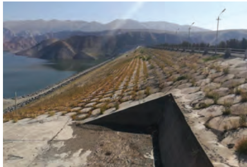
Рисунок 2 – Общий вид плотины со стороны водохранилища
