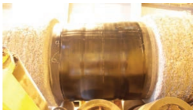
Рисунок 5 – Процесс установки манжеты типа ТИАЛ - МГП
