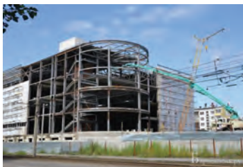
Рис. 1 Строительство четырехэтажного ТРЦ в г. Саратове
