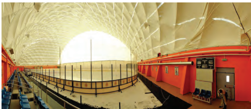
Рисунок 7 Воздухоопорное сооружение ледового катка пролетом 24 метра
