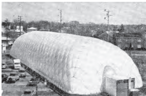
Рисунок 2 Воздухоопорное сооружение в СССР, усиленное канатами
