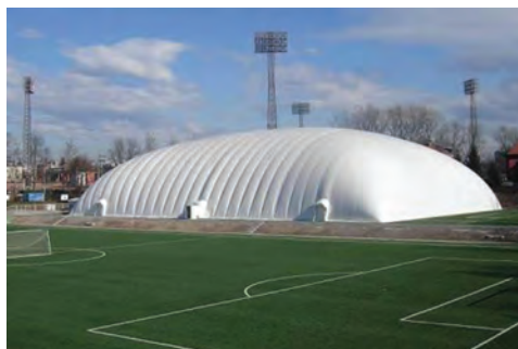
Рисунок 3 Пневматическое сооружение, усиленное канатами
