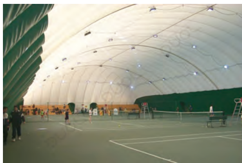
Рисунок 6 Пневматическое сооружение внутри которого расположен теннисный корт
