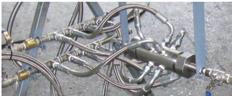
Рис. 1. Устройство для аэродинамической активации топливной смеси, адаптированное к топливной системе бойлера, производительностью в 10 тонн пара в час
