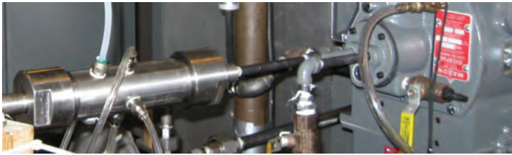
Рис. 3. Устройство для аэродинамической активации топливной смеси, подключённое к бойлеру, потребляющему дизельное топливо № 4 с производительностью в 1000 000 британских термических единиц в час
