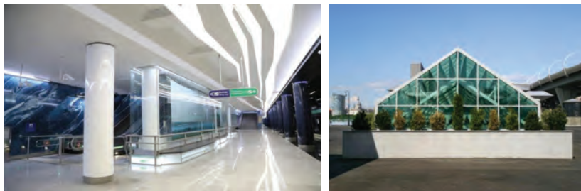
Рис.11 Платформа станции Новокрестовская Рис. 12 Прозрачная крыша вестибюля станции Новокрестовская
