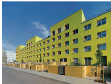
Рис. 2 (Снос этажей и пристройка территории для мини садов, рассчитанных на квартиру)
