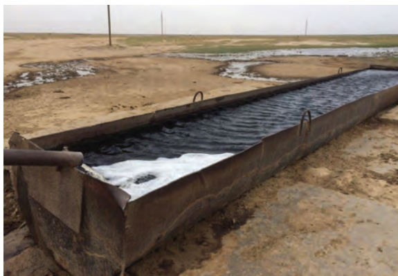
Фото 3. Скважина располагается на северном выезде из поселка, вода вытекает в солончак
