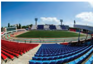
Рисунок 3 Реконструкция стадиона «Локомотив» июль 2014 г.
