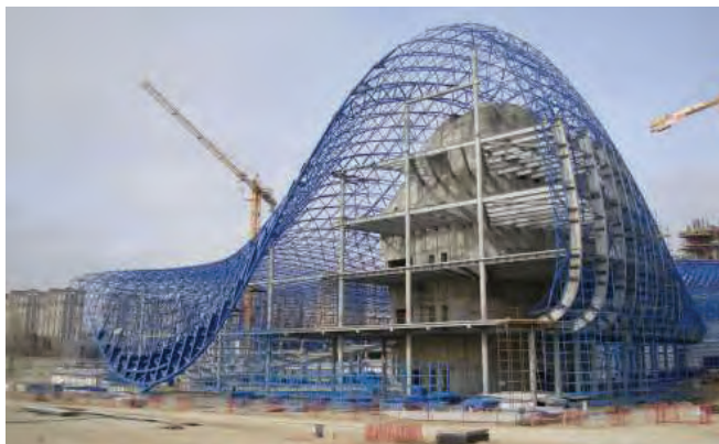
Рис. 3. Пример оболочечной каркасной системы
