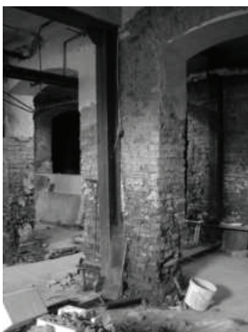
Рисунок 3 – Существующее усиление несущих конструкций
